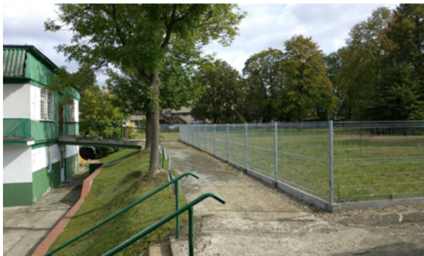
Dębica (2022). Miejsce, gdzie stał wyburzony w 2021 r. pawilon sportowy. Widok od strony płyty głównej stadionu. Po lewej część budynku KS Wisłoka, która obecnie wchodzi w skład Zespołu Stadionów Miejskich. Fot. arch. DZH
