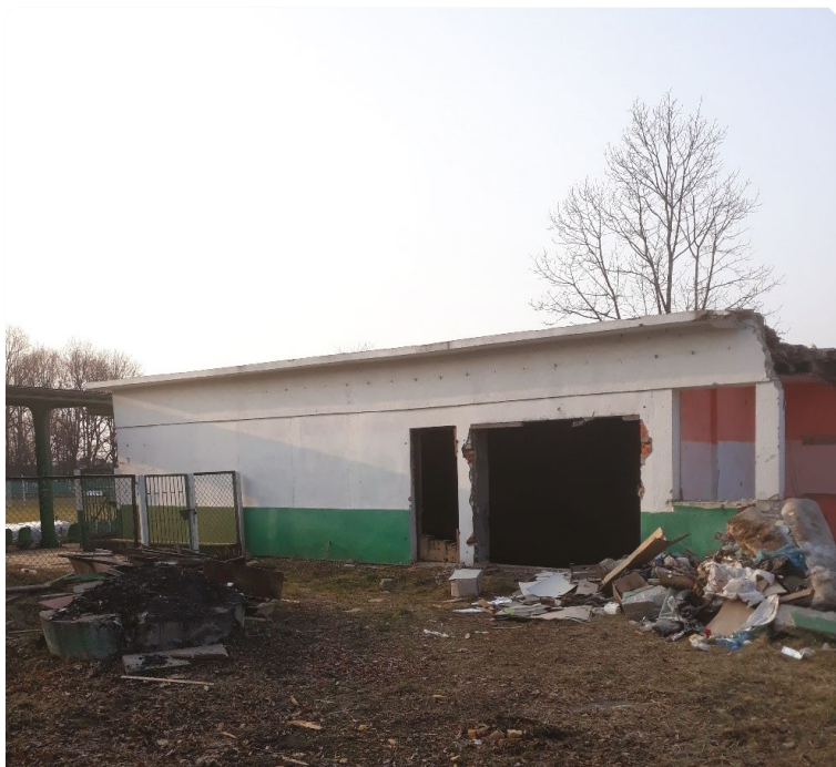
Wyburzanie starego pawilonu. Tutaj widoczna zachowana jeszcze część, gdzie była sala treningowa zapaśników.
