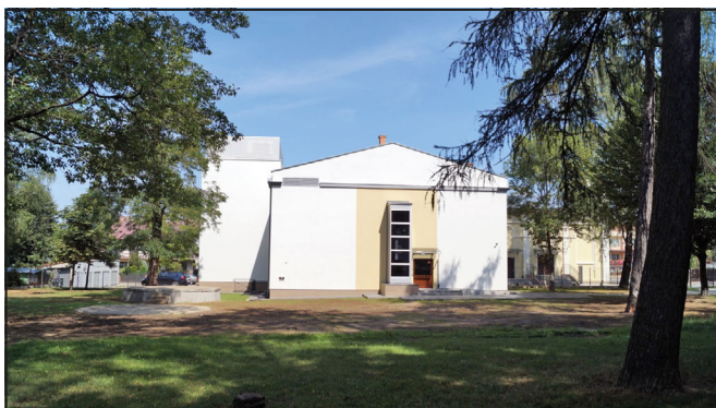
Widok ściany budynku od strony południowej w sierpniu 2019 r. po rozbudowie. Zdj. autora.
