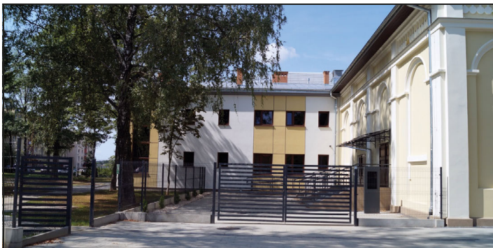
Widok tej samej ściany budynku w sierpniu 2019 r. Zdj. autora.
