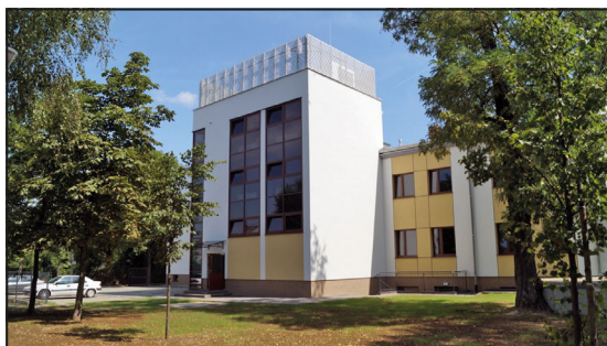
Widok zachodniej ściany budynku w sierpniu 2019 r. po kolejnej rozbudowie. Zdj. autora.
