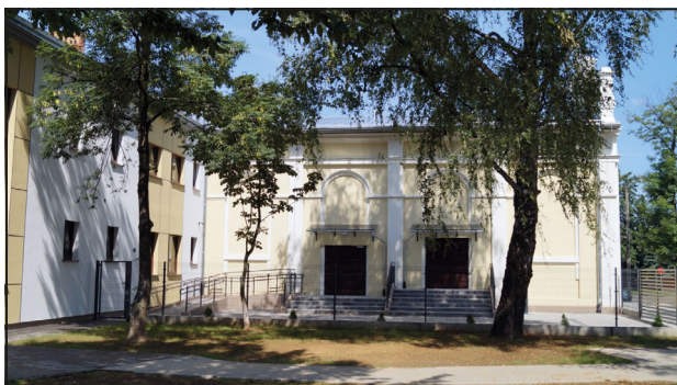
Widok tej samej ściany budynku w sierpniu 2019 r. Zdj. autora.
