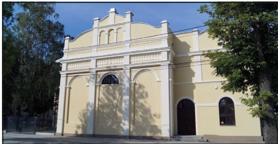
Widok ściany budynku w sierpniu 2019 r. Zdj. autora.
