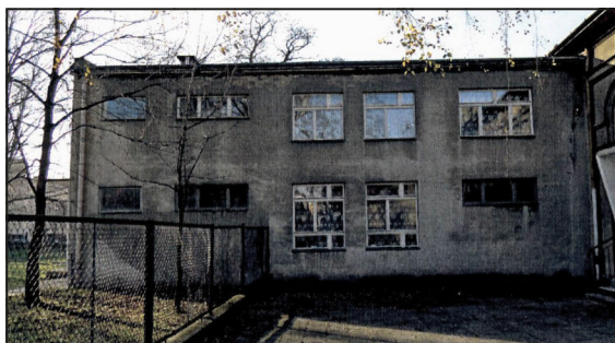
DK „Śnieżka”. Zdj. z dokumentacji WUOZ, rok 2015. Elewacja wschodnia nowego skrzydła.
