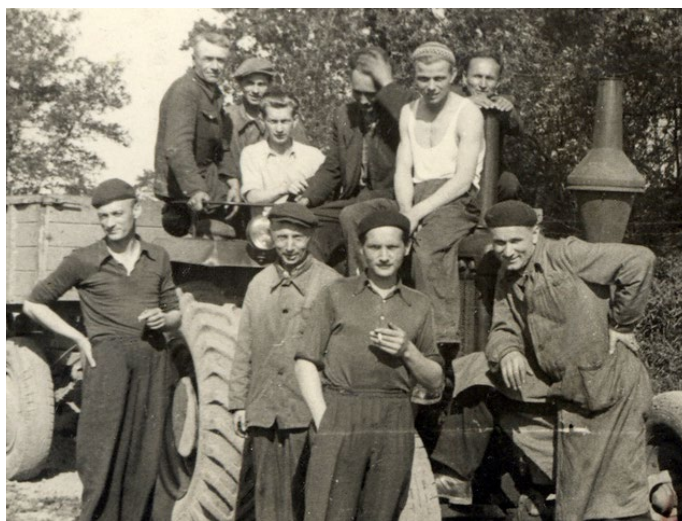
Dębica (między 1954 a 1969 r.). Zdjęcie Edwarda Brzostowskiego z okresu pracy w Zakładach Przemysłu Gumowego w Dębicy. Jako brygadzysta (pierwszy z prawej) stoi ze swoim zespołem koło ujęcia wody
