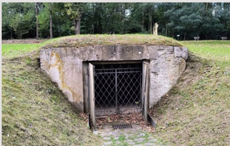
Komora do przechowywania ciał oczekujących na kremację
