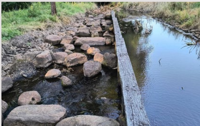
Kanał doprowadzający wodę z Potoku Chotowskiego
