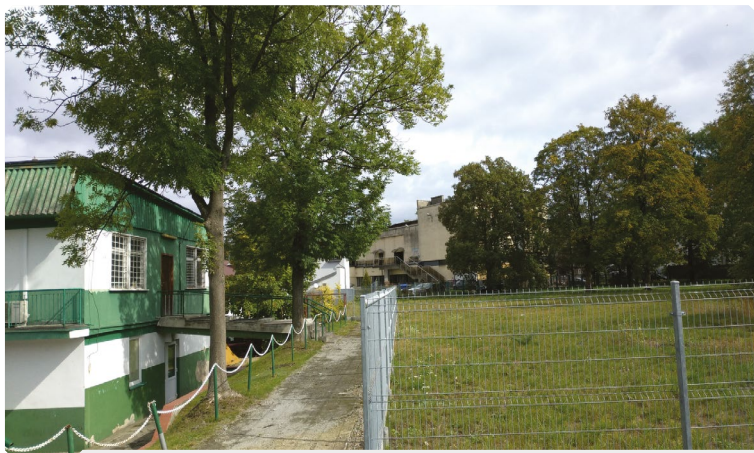
Rok 2022. Widok od strony płyty głównej stadionu. Po lewej część dawnego budynku KS "Wisłoka", obecnie wchodzącego w skład Zespołu Stadionów Miejskich. Po prawej działka na której stał stary pawilon KS „Wisłoka” z salą treningową dla zapaśników (tzw. „Kurnik”)
