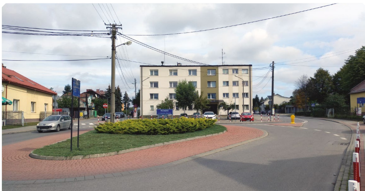
Dębica 2023. Dawny Hotel Robotniczy nr 3 oraz część ronda im. Ryszarda Świerada
