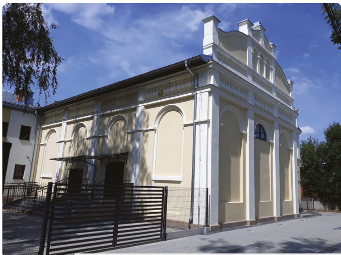
Wrzesień 2020. Dawny budynek PTG „Sokół” po rozbudowie oraz remoncie
