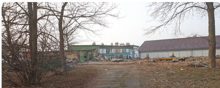
Rok 2021. Na wprost widać budynek MOSIR (dawniejszy nowy pawilon), po prawej sklep Biedronka, wybudowany na kortach tenisowych. Po lewej, fragmenty wyburzanego pawilonu
